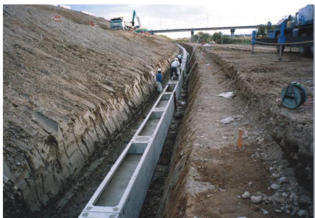
3 高さの半分までコンクリートを打設します
