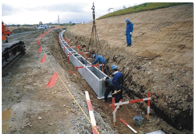
1 製品を施工位置に布設します
