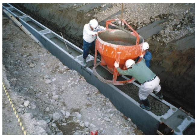
4 天端までのコンクリートを打設します
