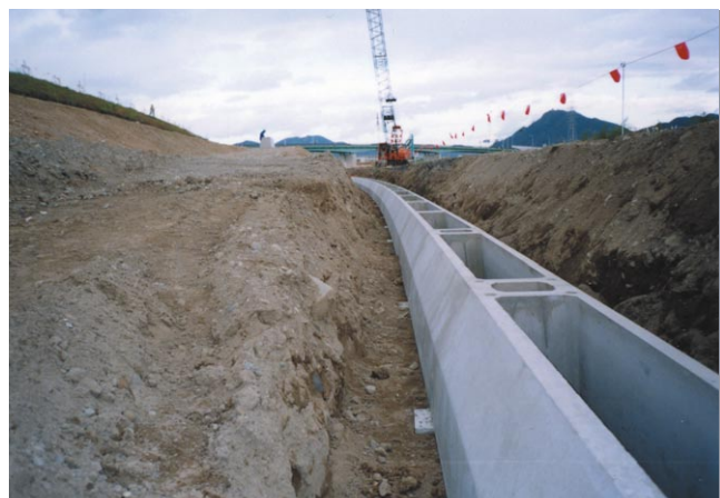
2 製品布設完了
