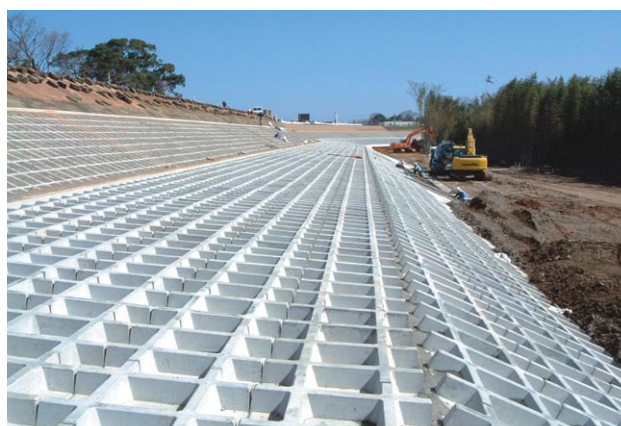
ブロック敷設直後
