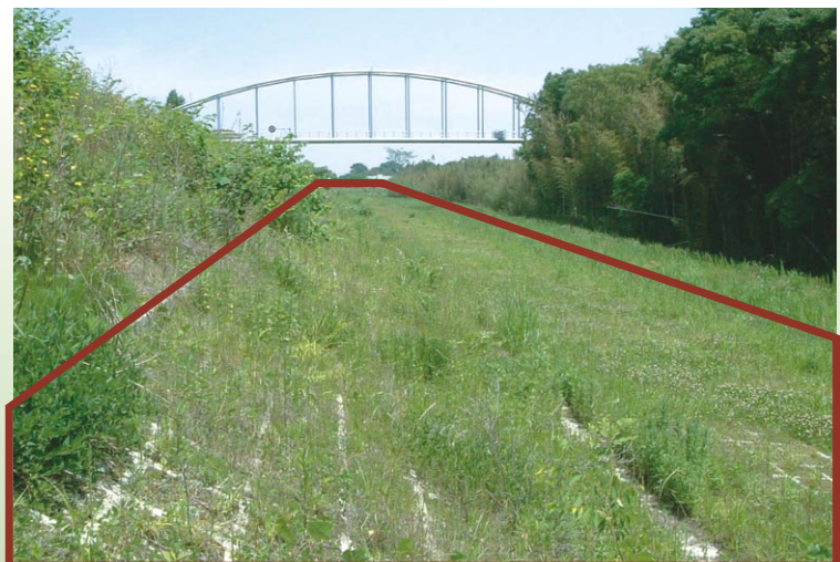
施工後2年目 撮影時期7月
