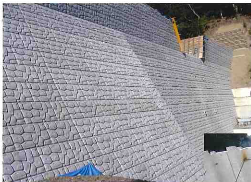
砂防堰堤用転生型枠
