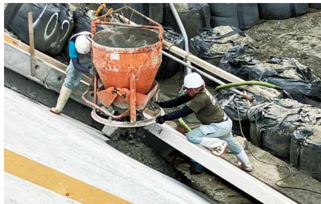
中詰めコンクリート打設
