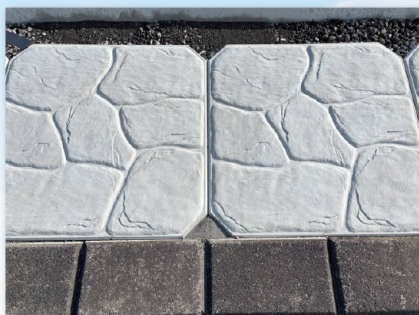
令和7年度 揖斐川福島高潮堤防嵩上工事 株式会社 久志本組
